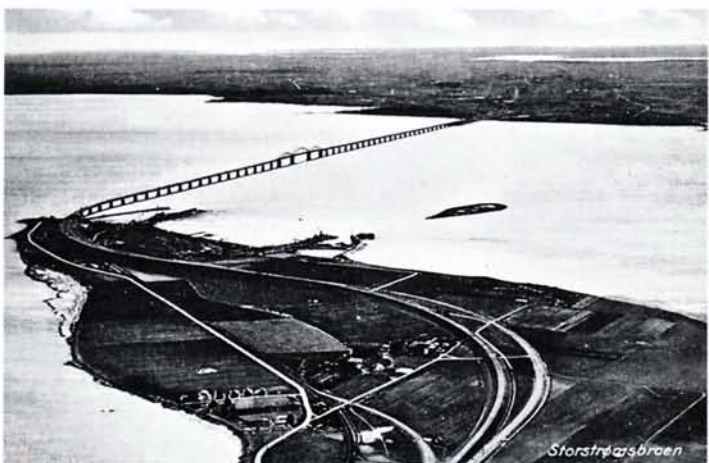
Op 26 september 1935 werd de 3200 meter lange vaste oeververbinding over de Storstrøm geopend en kon de spoorveerdienst tussen Masnedø en Orehoved worden gestaakt. Prentbriefkaart.
